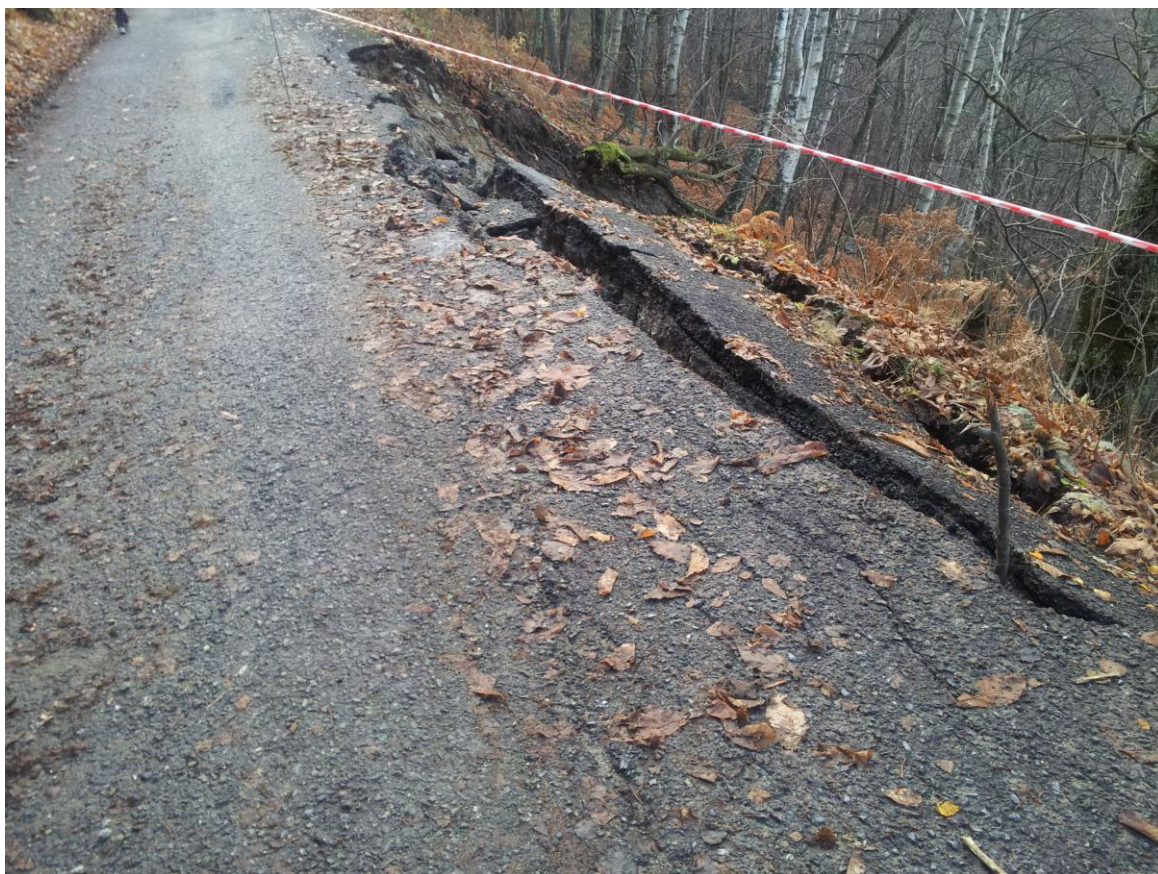
Foto 3: intervento 1 - particolare della nicchia di distacco che coinvolge la sede stradale
