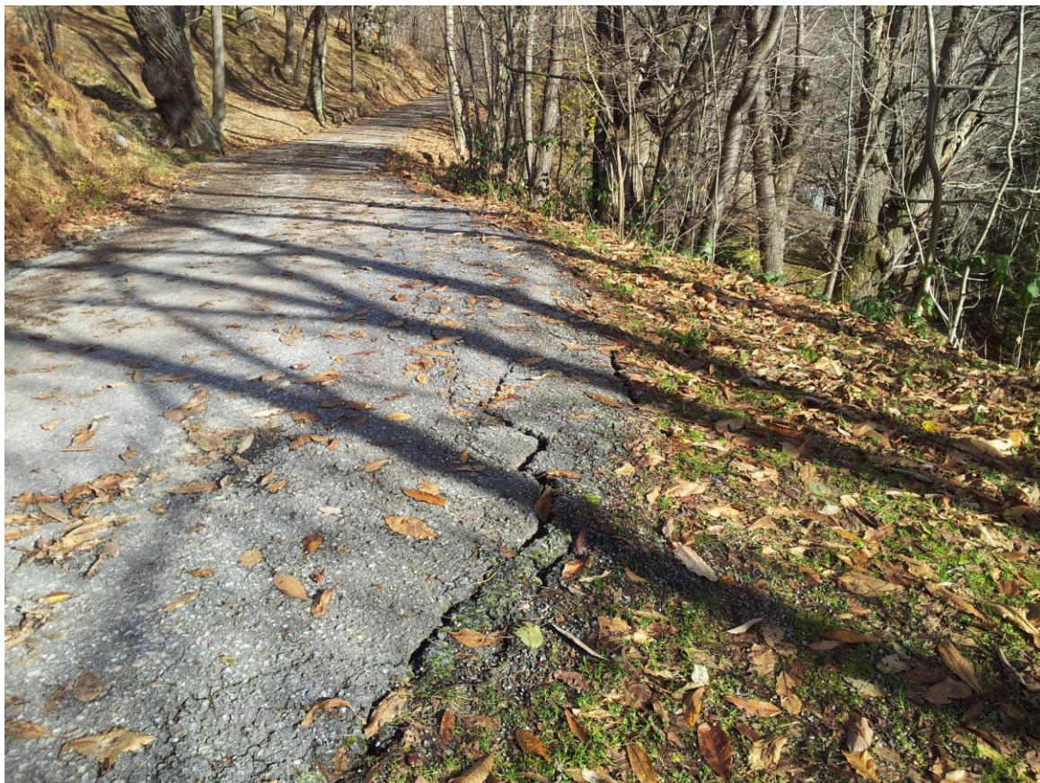
Foto 5: intervento 3 - movimento franoso a valle della strada con evidenti tagli nella pavimentazione
